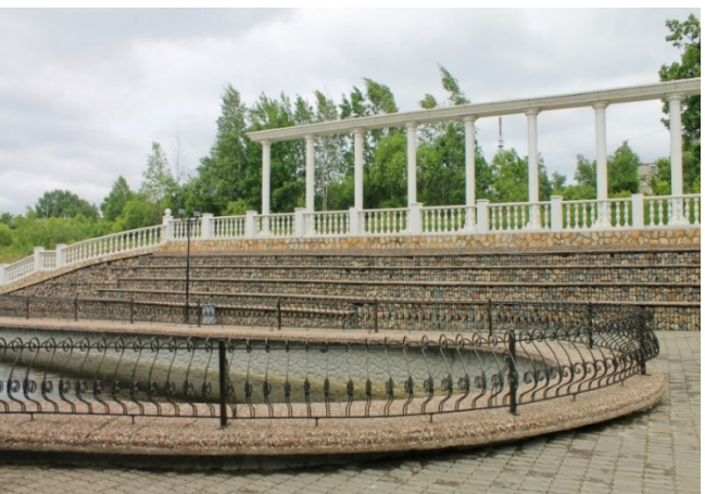
Рисунок 3. Укрепление склона оврага при помощи габионных конструкций. Парк «Северный». Г. Хабаровск
