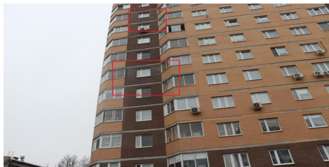
Рис. 5. Участки фасада со следами высолов на облицовочной кирпичной кладке
