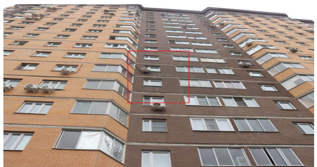
Рис. 5. Участки фасада со следами высолов на облицовочной кирпичной кладке
