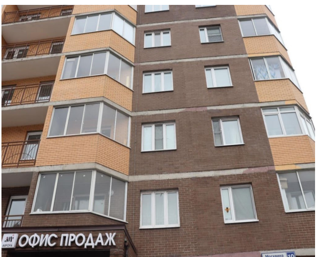
Рис. 3. Локальные участки с штукатуркой и окрасочным слоем на торцах плит перекрытия
