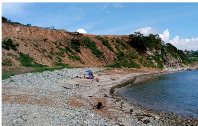
Рисунок 1, б. Состояние склона в начале строительства. Плоскостной смыв почв. Поселок Южно-Морской Приморского края
