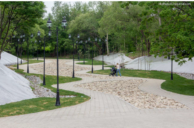
Рисунок 2б. Каменный ручей над трассой донного дренажа оврага. Завершение строительства. Июнь 2012 г.
